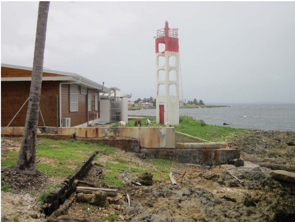
152 qui présente un secteur rocheux pouvant s'avérer dangereux.
