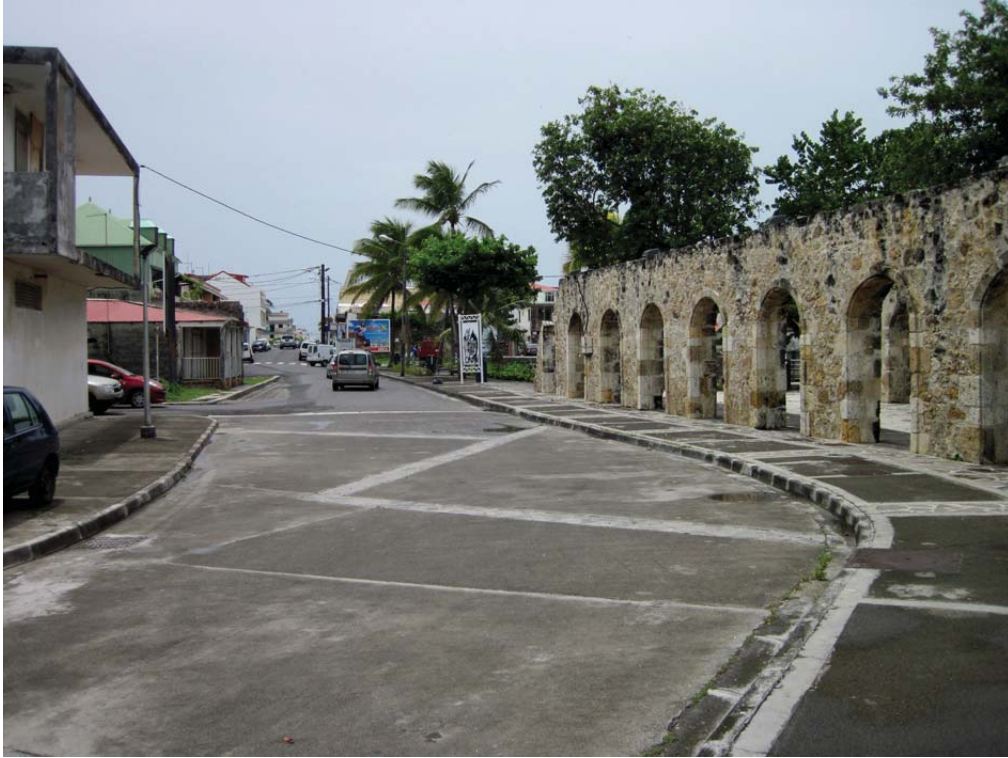
164 chemine sur le trottoir devant la parcelle section n° AP 204,
