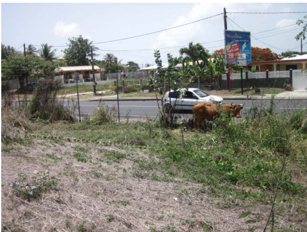
122 Vue sur la clôture séparant le domaine public routier de la parcelle n°307.
