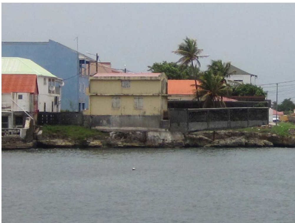
160 La parcelle vide section AO n°429 se trouve à gauche de la maison jaune, dans l'axe de la façade bleu, permettant d'apprécier le blocage physique de ce front de mer.
