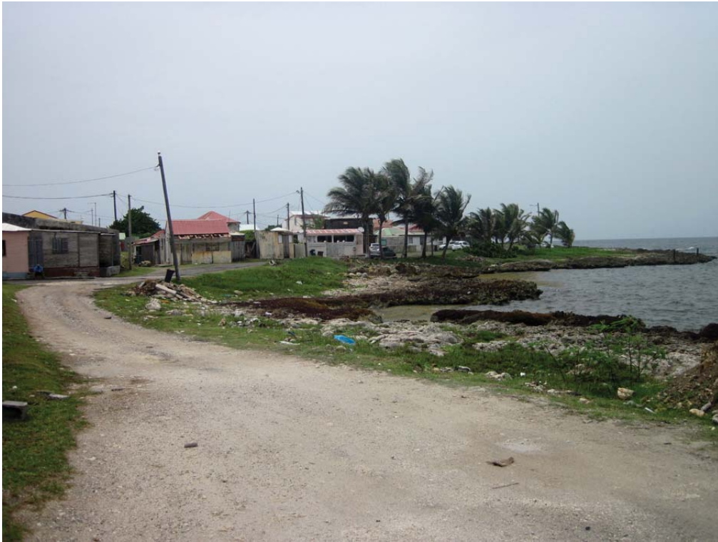
140 Le sentier du littoral progresse le long de la rue du commandant Cousteau sur la parcelle section AO n°919,
