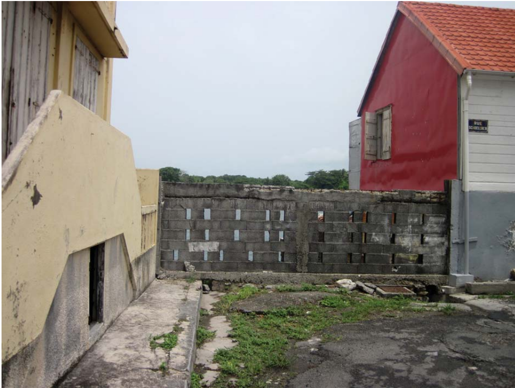
158 Derrière le mur en parpaing apparent, la parcelle section AO n°429 au croisement de la rue du Général Lacroix et de la rue Schoelcher.
